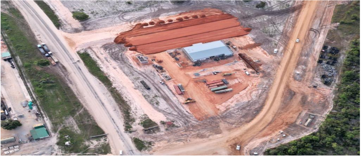
परियोजना स्थल पर सड़क निर्माण
